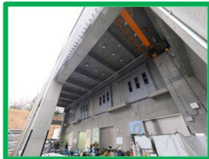
各計測制御機器室入り口と MTB吊上げクレーン
