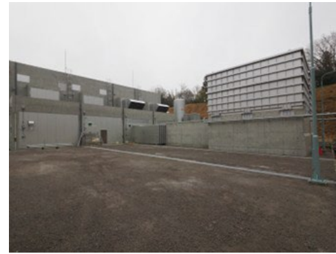
煙道・消音塔(西から)
