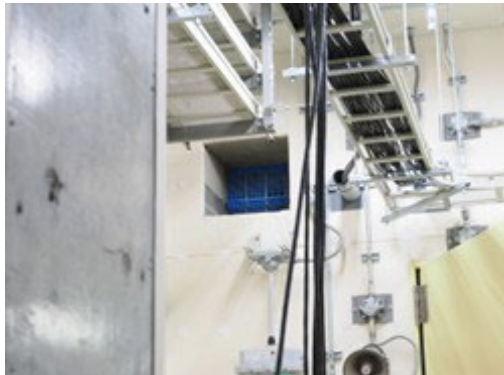
⑥防爆/非防爆エリアの境界にケーブルを通すMCT（マルチケーブルランジット）
