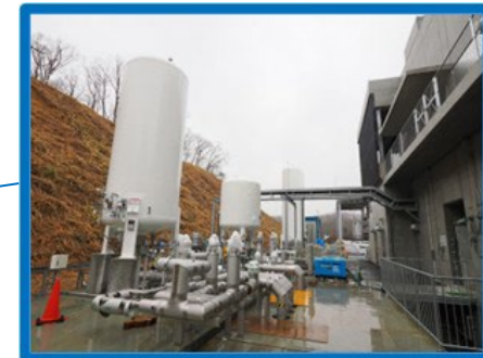
酸化剤系高圧・低圧ランタンク
